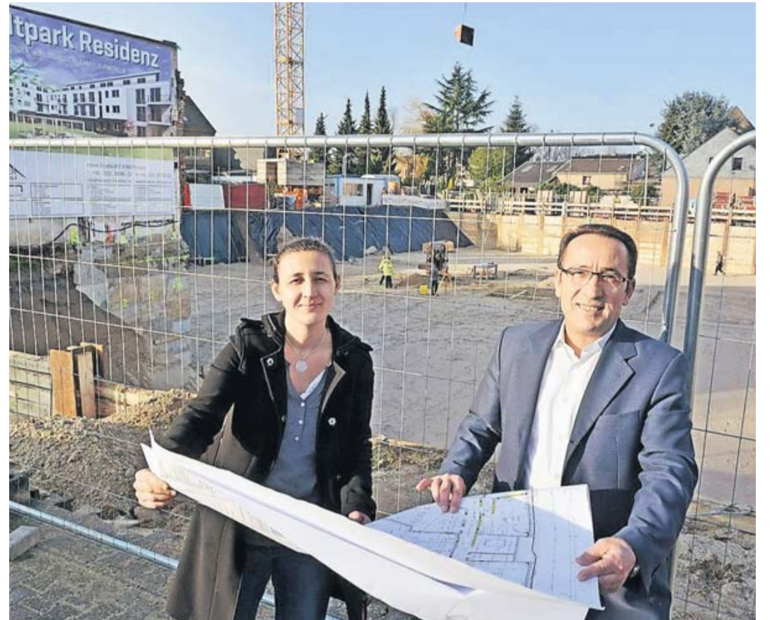
Der Zeitplan steht: Der Rohbau für die „Stadtpark Residenz“ an der Kölner Straße 467 beginnt. Cevdet Bekmezci (r.) und seine Tochter Gönül sind die Bauherren. 2016 soll alles fertig sein. Foto: Andreas Bischof
